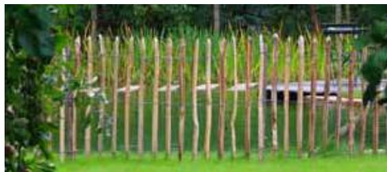
I paletti sono legati con filo galvanizzato con diametro di 1.8 mm (95% Zinco e 5% alluminio) resistente agli agenti atmosferici e testato anche in ambiente marino (sulle spiagge).
